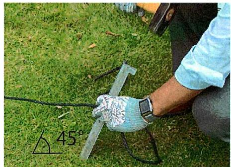
③最初に建てたポールの対角のポールを建て、ロープを張ります。残りのポールも対角の順序で建てます。
